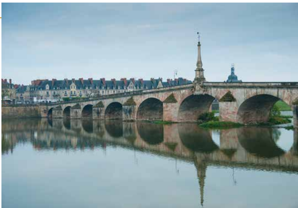
← Le pont Gabriel de Blois, sur la Loire, 1716-1730, avec la croix qui marque son milieu.
